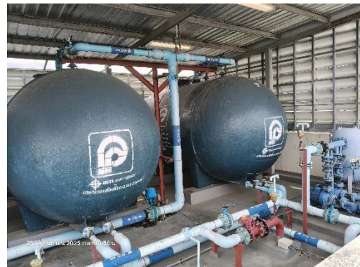
ถังสำรองน้ำดับเพลิง อาคารละ 2 ถัง
